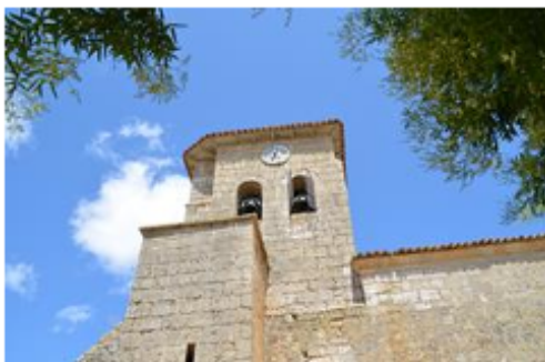
Detalle de campanario de la iglesia
