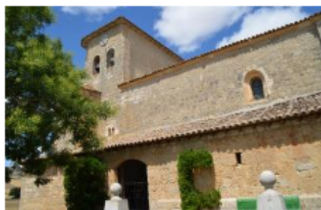
Iglesia, detalle del pórtico y entrada.
