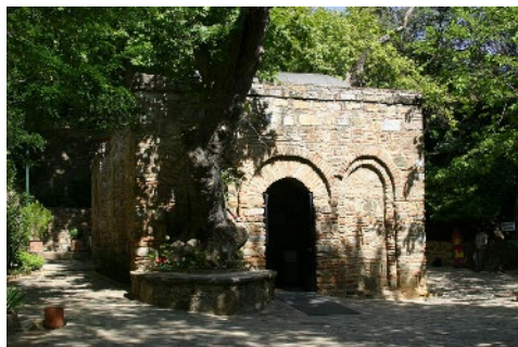
Exterior de la casa restaurada que ahora sirve de capilla.
